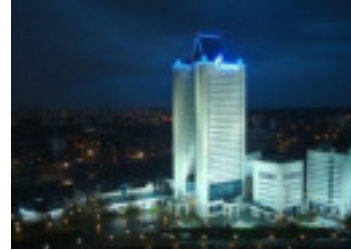
Data-центр ПАО «Газпром» г. Москва
