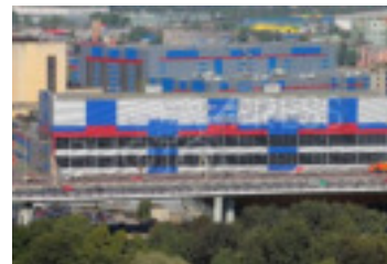
Завод ОАО «Концерн ПВО «Алмаз – Антей» в производственно-технологическом кластере «Северо-Западный региональный центр» г. Санкт-Петербург
